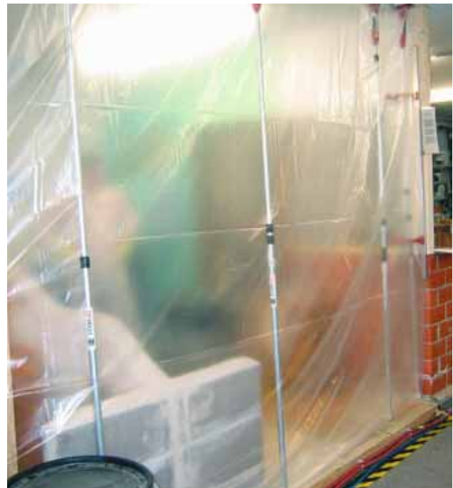
Bild 4: Schwarz-Weiss-Trennung durch Abgrenzung mit Plastikfolie.
